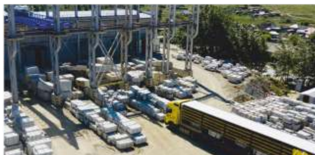
Ж/Д тупик на станции Учалы
